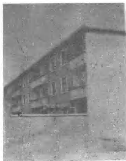
县粮局宿舍楼
