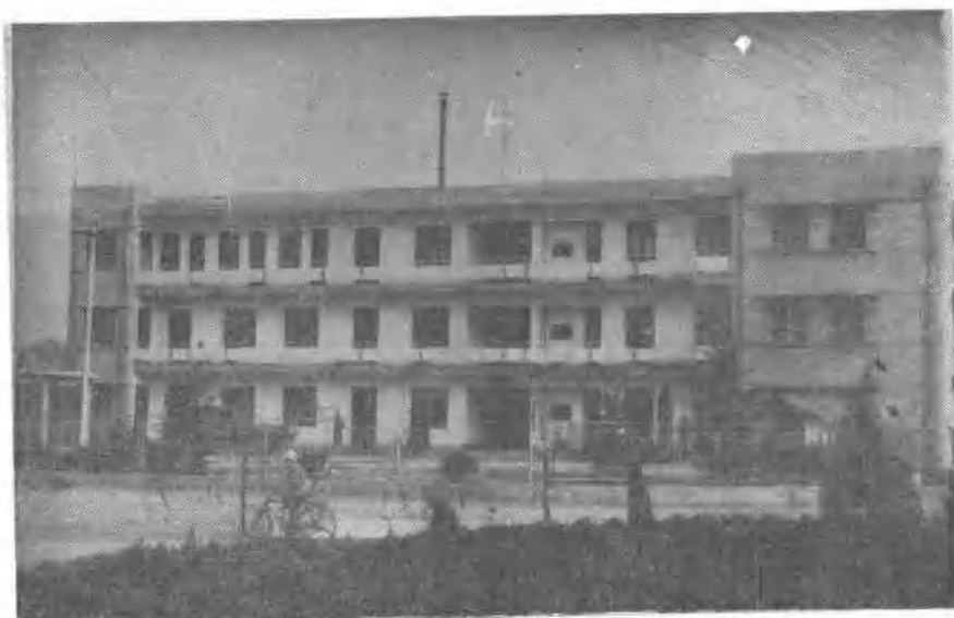
县粮局办公楼
