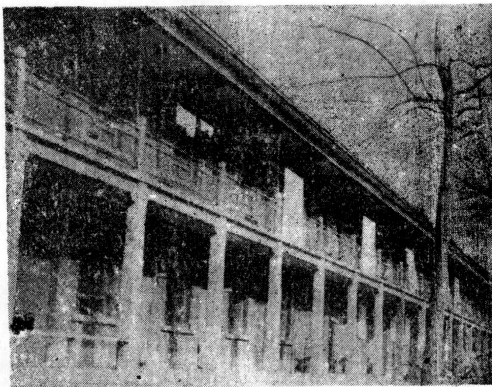
县防疫站办公宿舍楼
