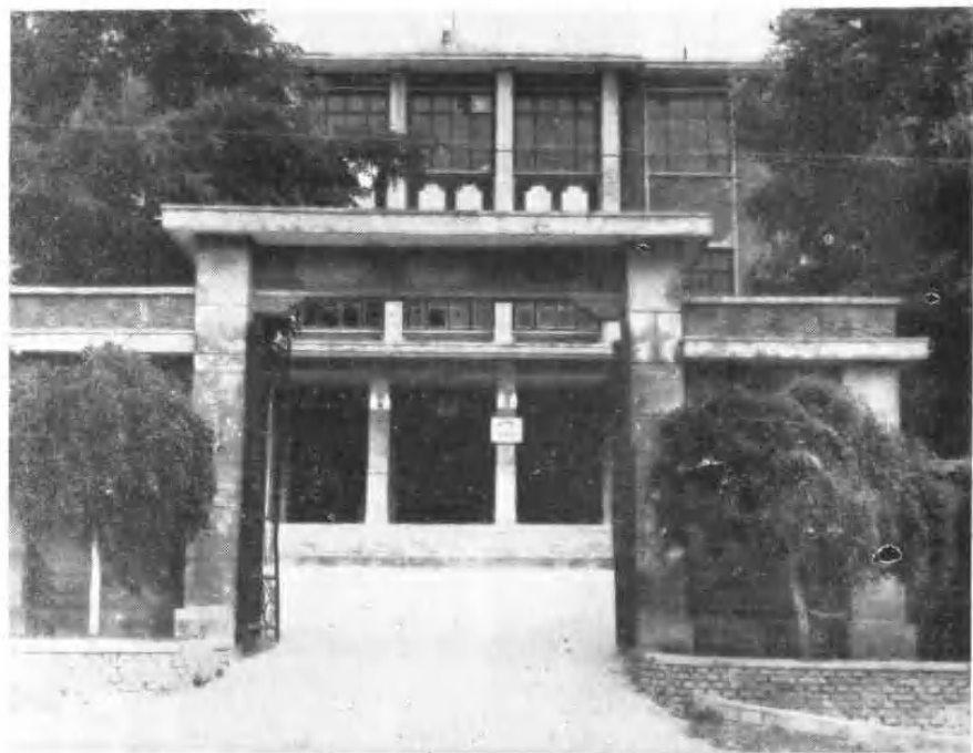
舞钢区卫生防疫站、药品检验所办公楼
