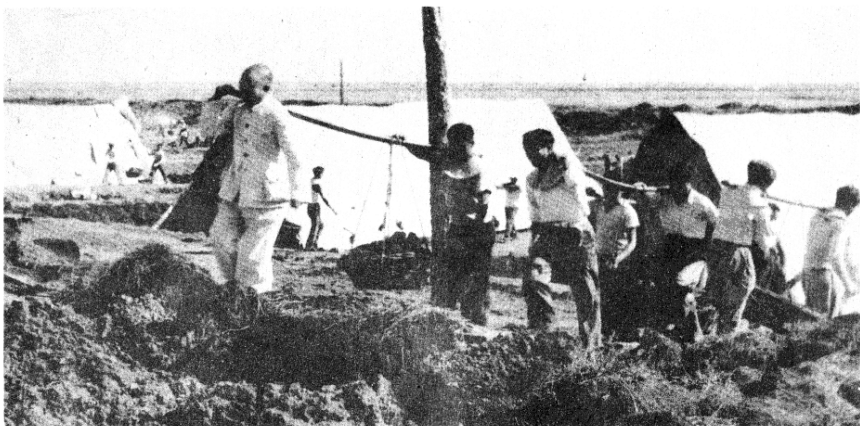
云山水库工地上王震将军亲临现场并和战士们一起抬筐填土
