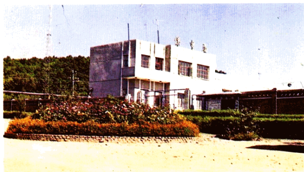
1989 年建成的 云山变电所主楼
