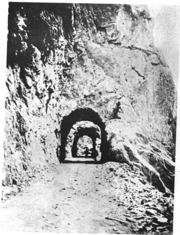
西漢公路第二號山洞。
