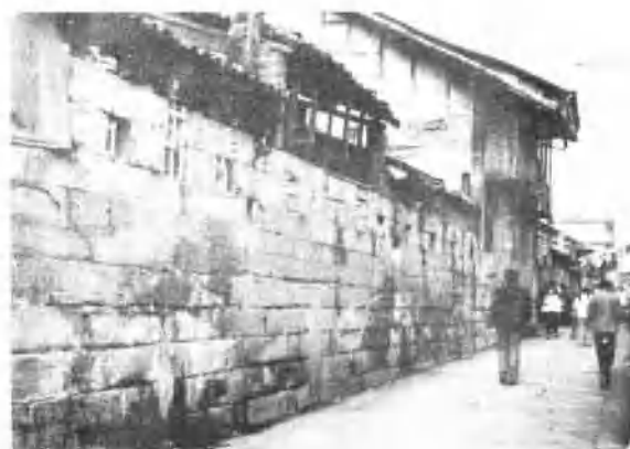
荣昌县昌元镇城墙
