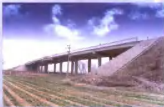
▲跨越铁路立交
