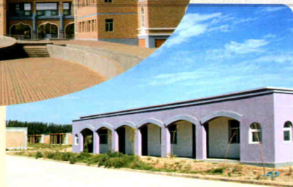
和田市浙江亚布拉克新村建设
