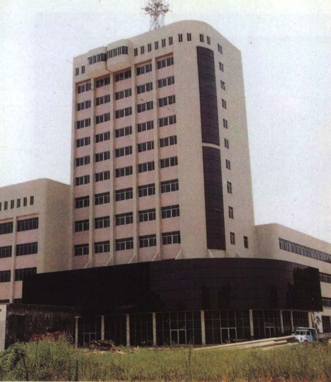
◀ 新建的邮电大楼
