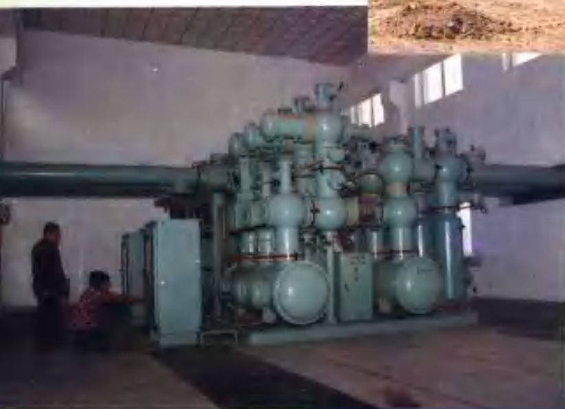
首次在嵩山变电站安装国产 110千伏六氟化硫电器组合设备
