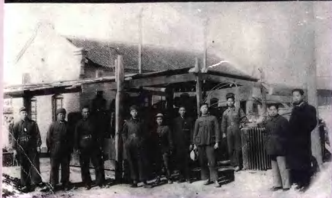
原鄭州明遠電燈公司安裝50千瓦和75千瓦柴油發電機組
