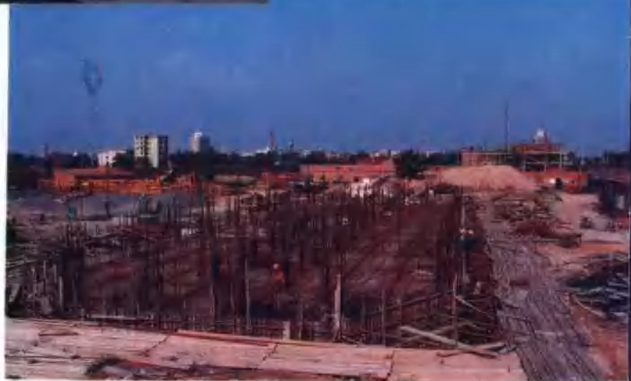
建设中的局新 基地办公大楼
