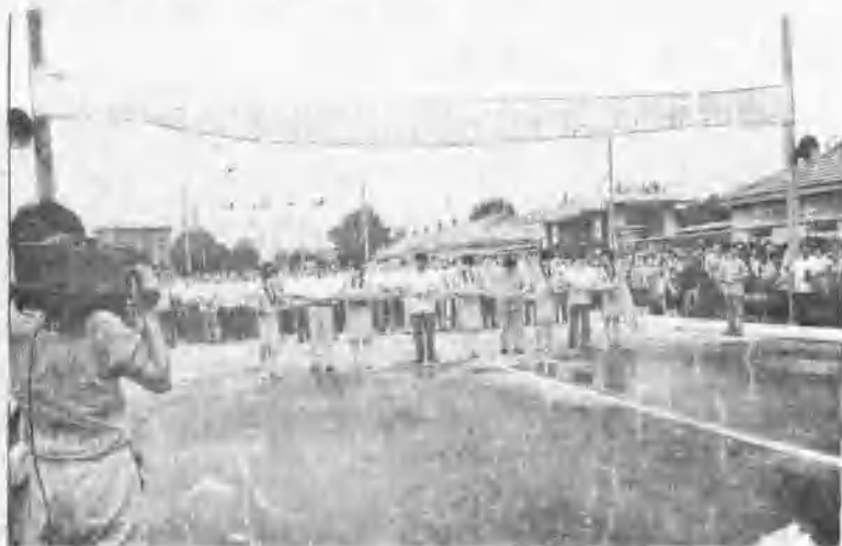
广饶县动员了全社会的力量来进行村村通柏油路的建设
