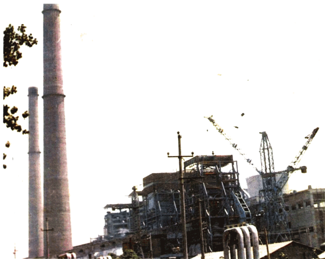
正在施工中的焦作电厂主厂房
