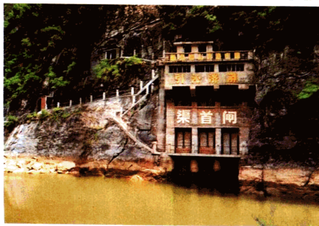
引沁总干渠第一渠首闸
