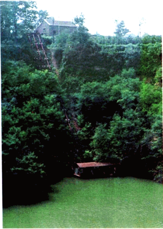
汤庙水库提灌站
