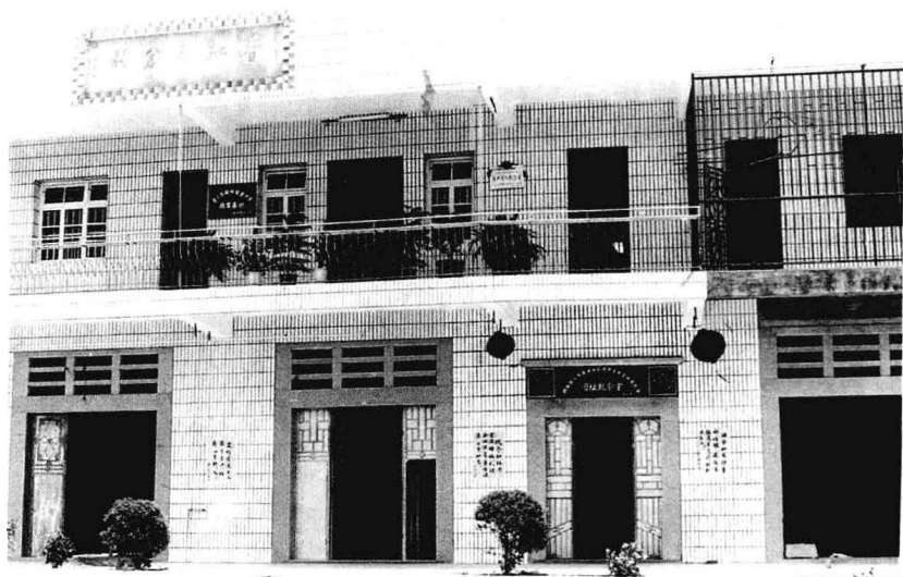
图为闽浙赣人民游击纵队闽中支队泉州团队部旧址纪念室(二楼)
