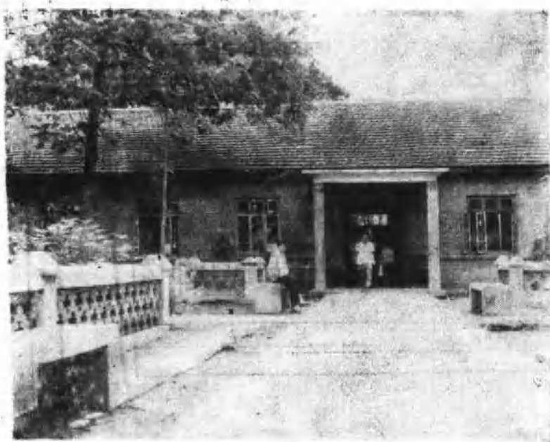
西华县人民医院病房外貌
