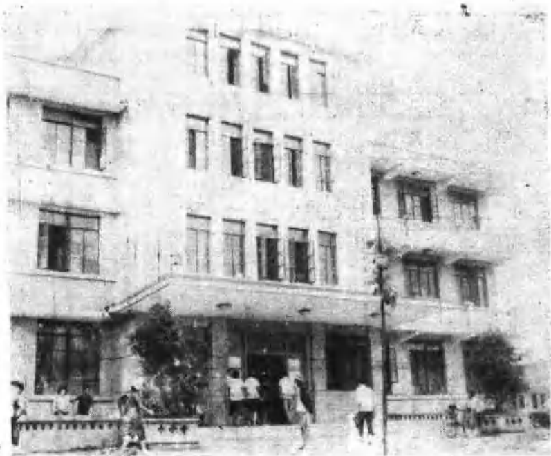
西华县人民医院门诊外貌
