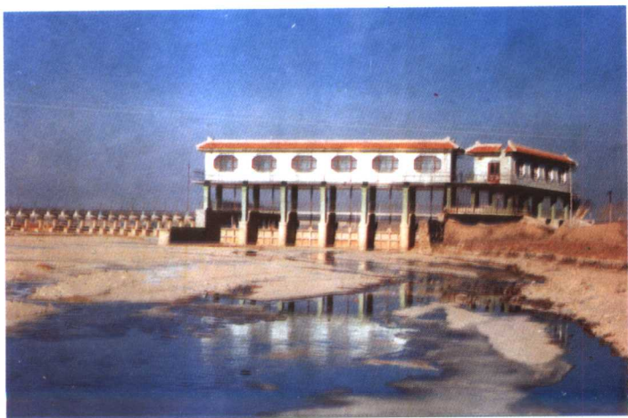
洋河二渠渠首工程
