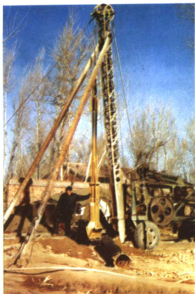
县机井队在岸庄屯村打井
