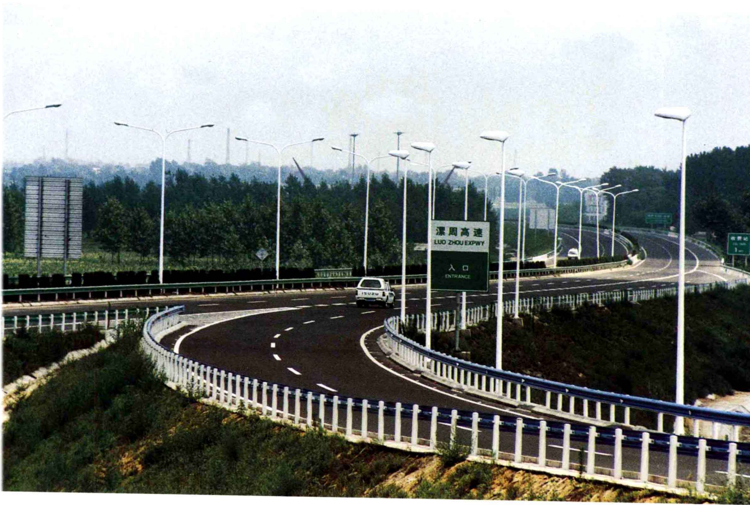
周漯高速公路
