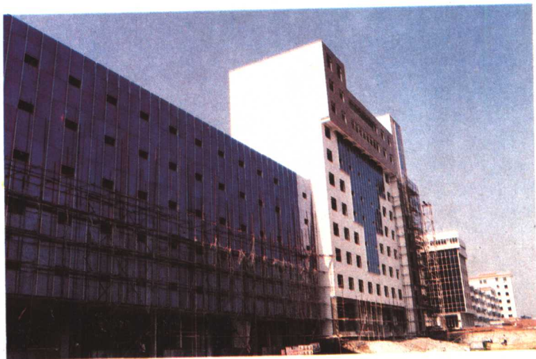
威海城建开发公司建设的 2.35 万平方米的寨子 11 号综合楼
