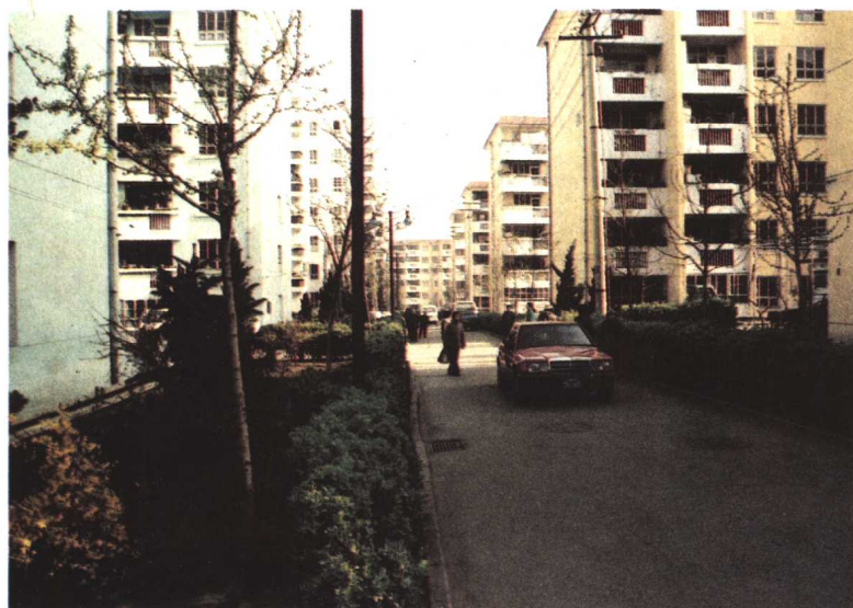
公司承建的获中房集团工程质量管理金奖的民生住宅小区
