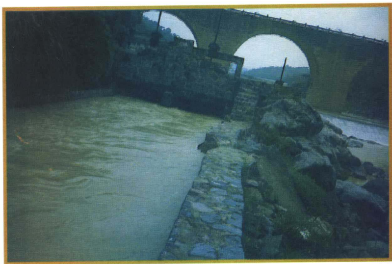
澳江右干渠渠首控制闸
