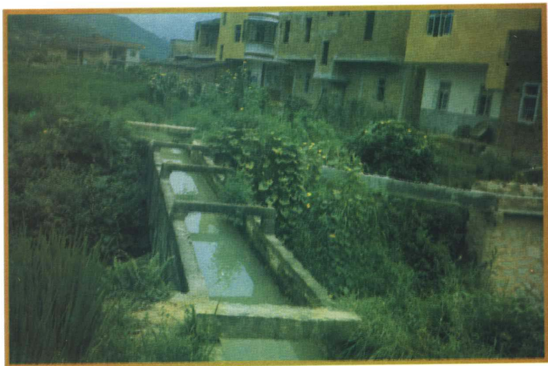
澳江渠左干渠新坝坑钹渡槽
