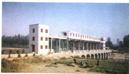
商水县汾河雷坡闸
