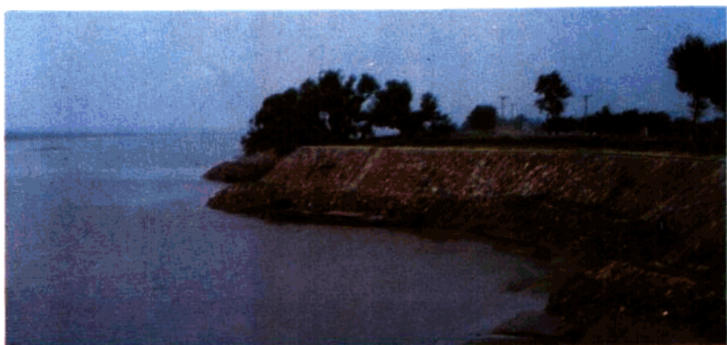
黑岗口险工盖坝 马刚 摄
