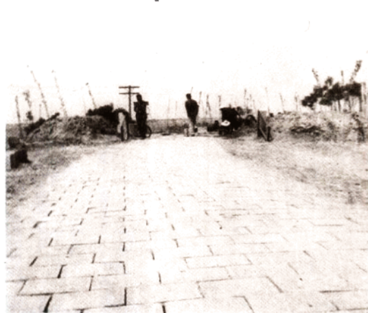
竣工后的堤顶硬化路面 胡锡焱 摄
