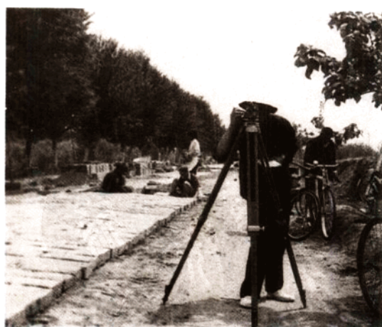
铺设堤顶硬化路面 胡锡焱 摄
