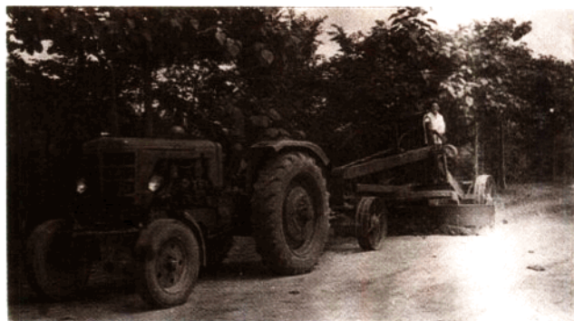
用刮板机刮平堤顶 徐尧虎 摄
