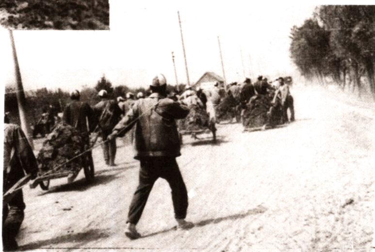
架子车运土修堤
