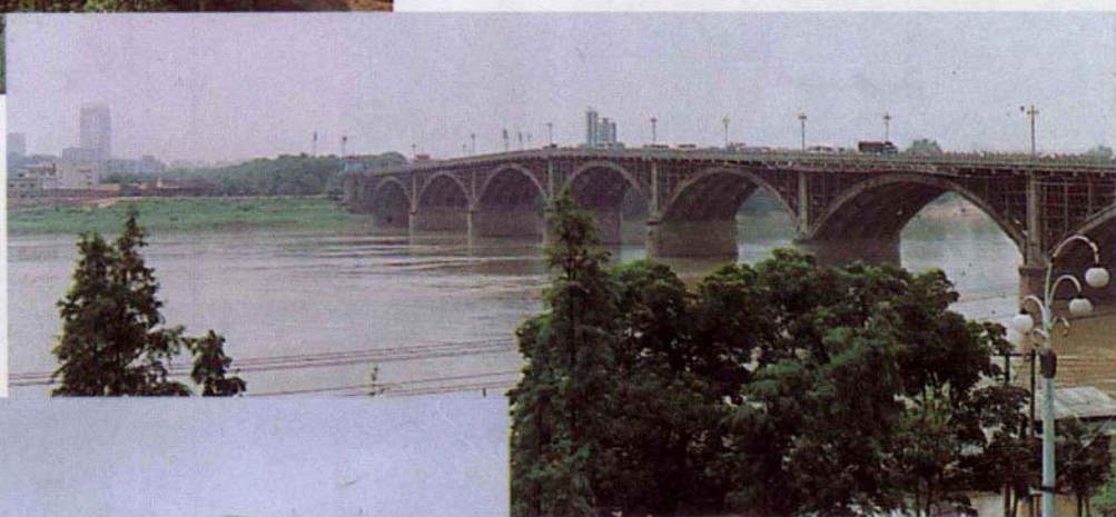
始建于 1960 年的湘江第一桥——连接湘潭东、西城区的湘潭公路大桥
