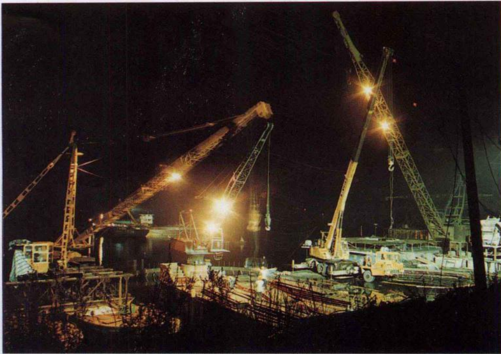
工地夜间施工场景
