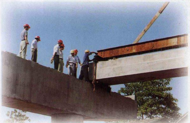
第一片梁现场吊装
