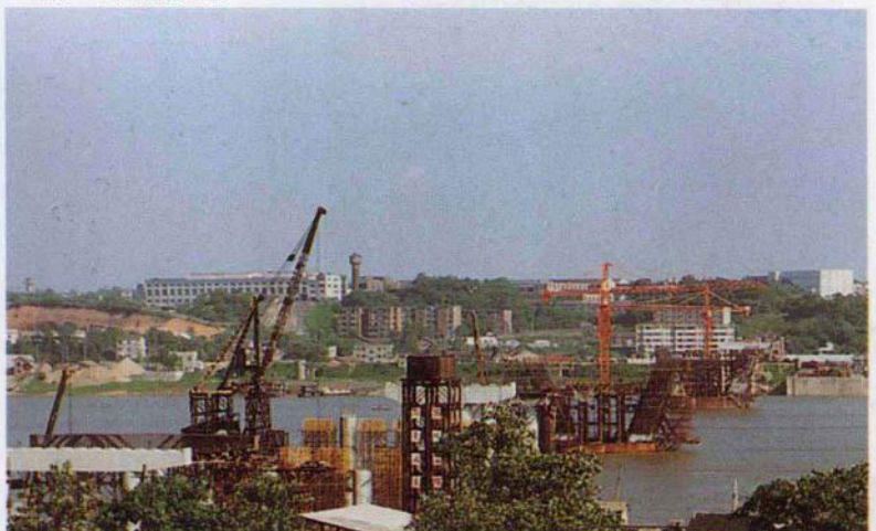
丰水期间主桥施工场面
