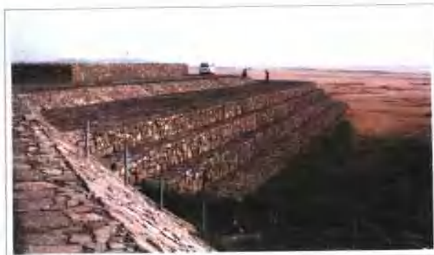
◀ 清涧湾调蓄工程一号坝头
