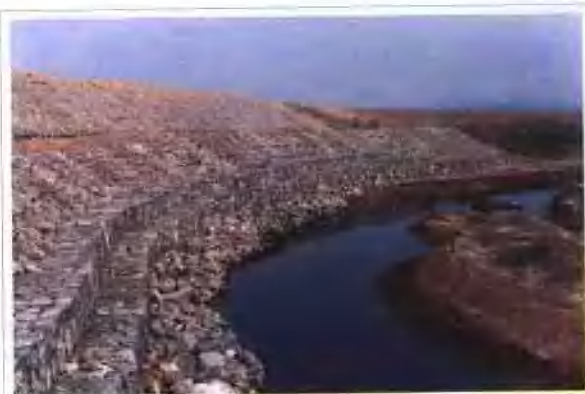
▶ 汾河山王渡护岸工程
