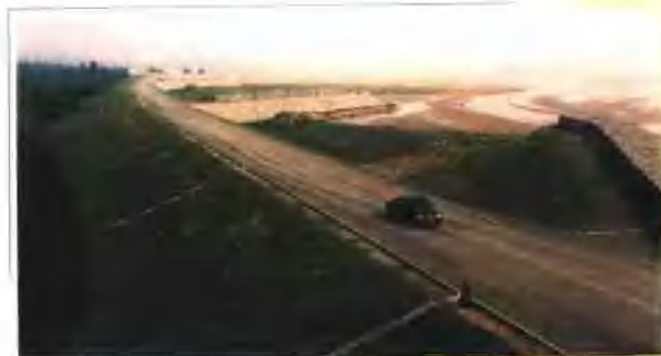
◀ 禹门口控导工程
