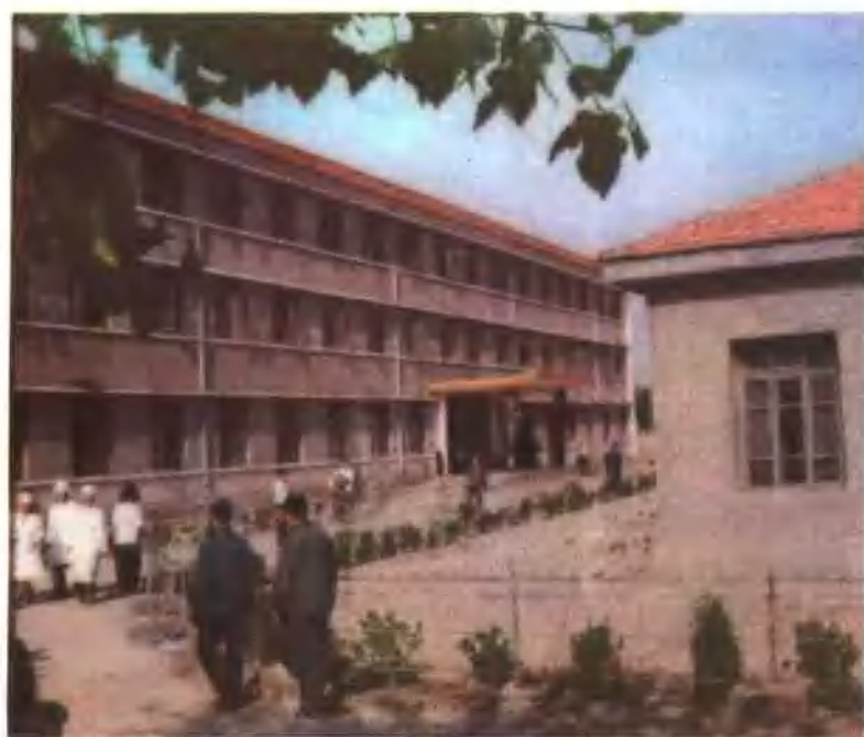
原阳县人民医院病房楼
