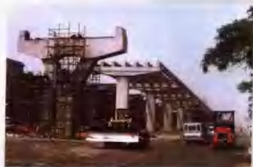
铁铝酸盐水泥用于北京立交桥的浇注。（照片提供 苏慕珍）
