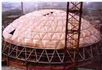
用GRC三角锥壳建成的直径45米的济南汽车站候车厅。（照片提供 曹永康）
