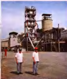
1991年，我院承担工程设计的我国出口的第一条700t/d水泥预分解生产线在泰国萨拉布里水泥厂落成。（照片提供 赵正一）
