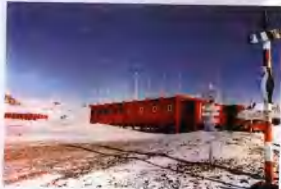
硫铝酸盐水泥应用于冬季施工的南极考察站。（照片提供 苏慕珍）
