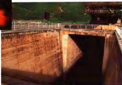
承受火箭发射烈焰的导流槽。 （照片提供 院档案室）
