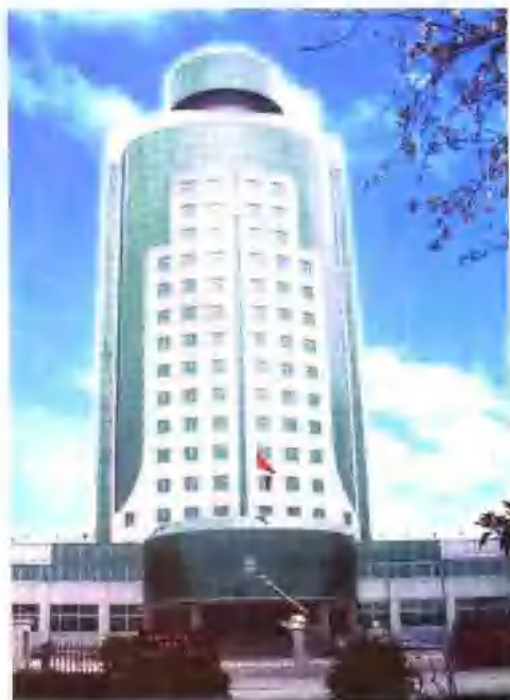
依靠多元化投资渠道兴建的襄樊市广播电视中心
