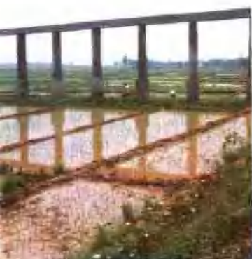
国家大型商品粮基地项目——龙王镇柏营渡槽旱改水样板田
