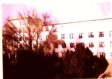
▲县医院住院楼
