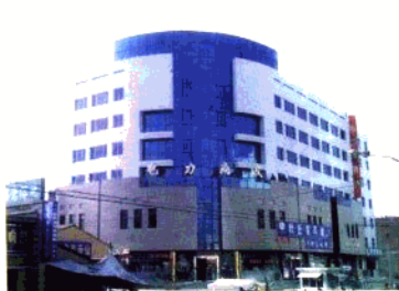
▲陇西县电力局综合办公楼
