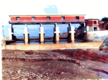
▲渭北电力提灌工程冲沙闸
