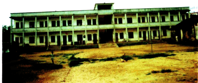
△化州市良光 老区镇良光小学新 建的教学大楼。
