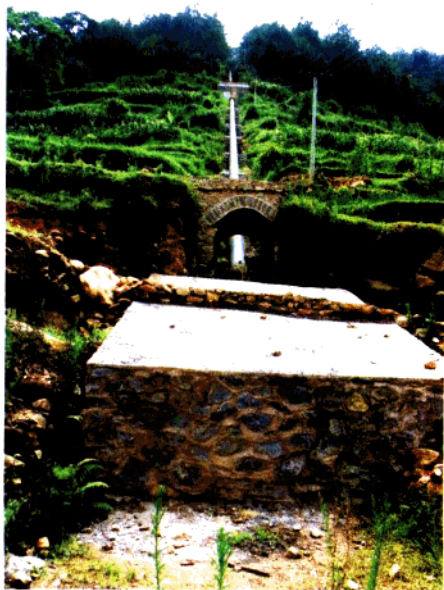
▷信宜市洪冠镇 洪燕老区水电站， 2200米引渠外景。
