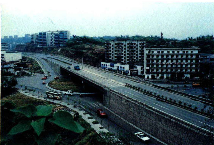
毛线沟立交桥
