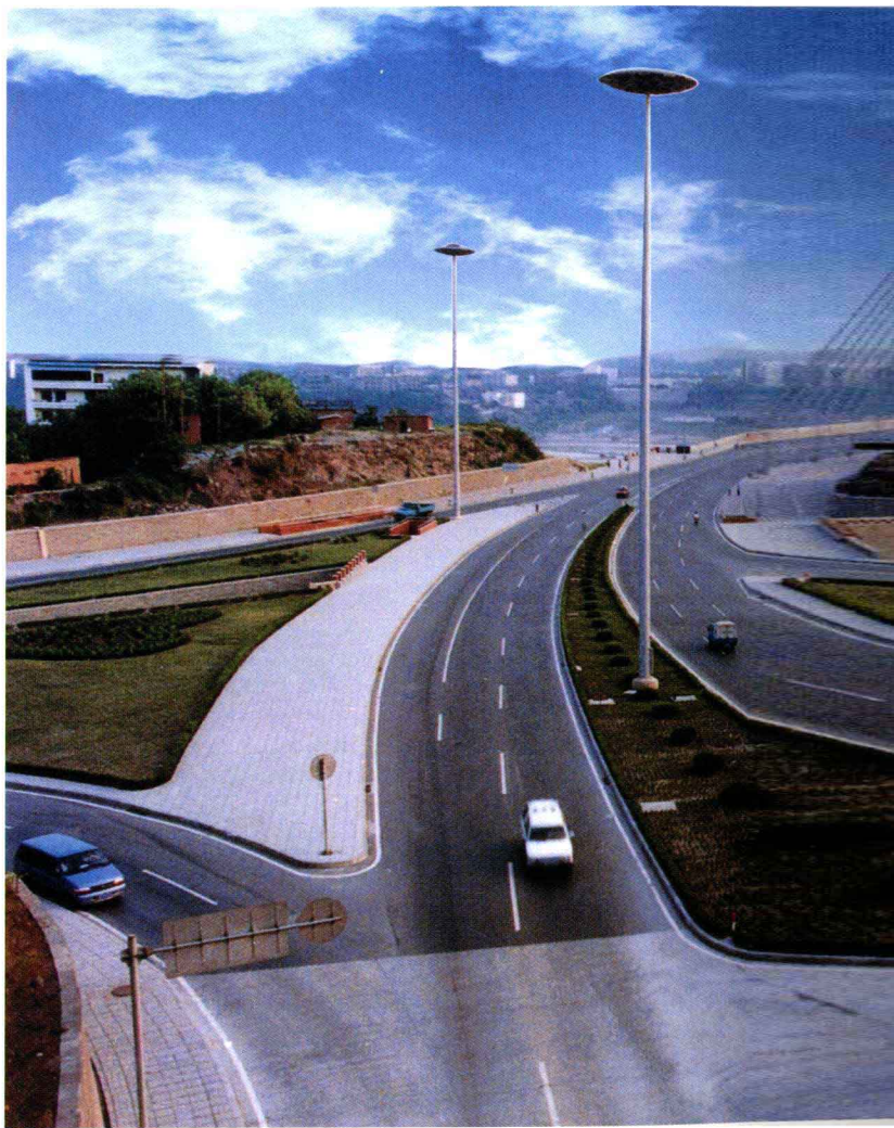
长江李家沱大桥北桥头立交
