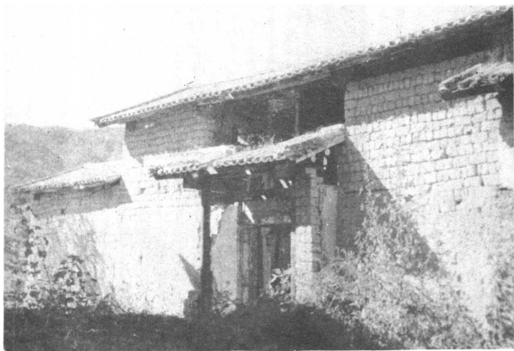
6、中共兰坪中心县委·滇西北专员公署第一分署旧址 ——通甸街财神殿 (葛诚忠 摄)
