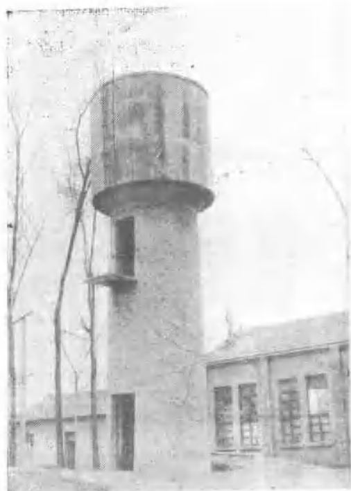
程庄乡南湖村新建水塔
