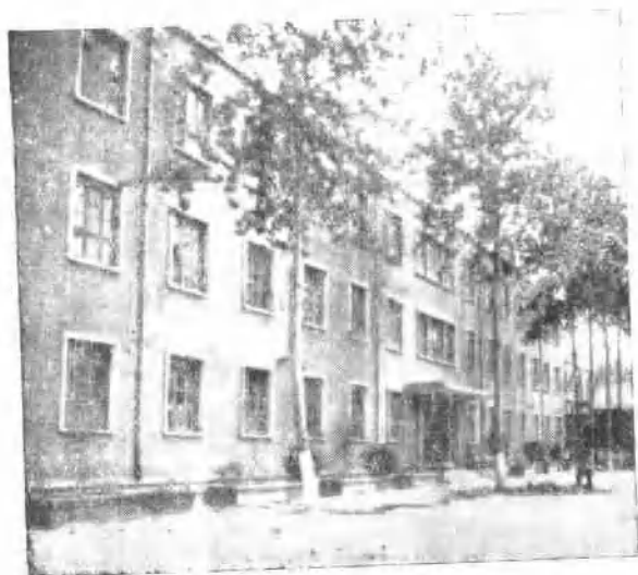
一九七五年建成的办公检验楼
