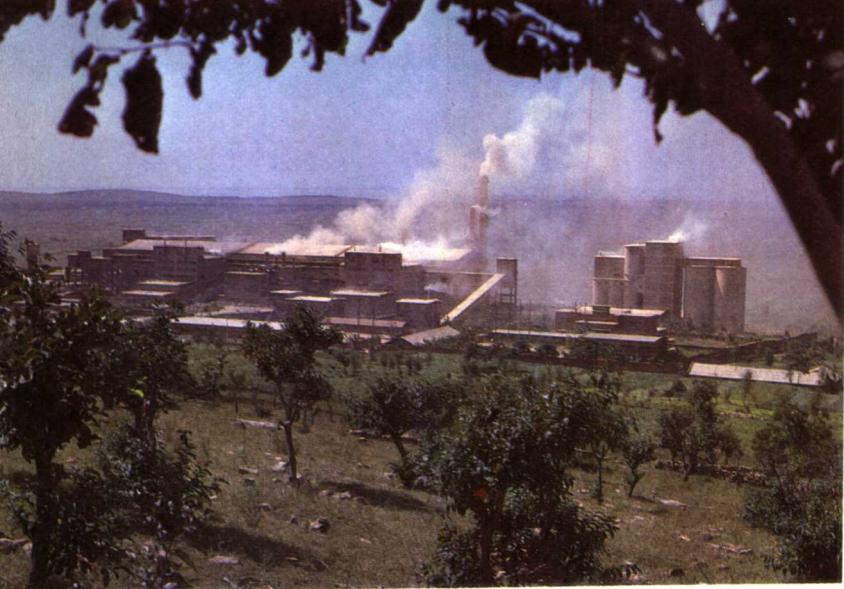
平顶山水泥厂
