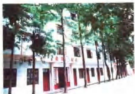
▲ 县林业局机关办公大楼
