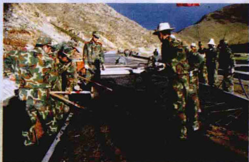
武警交通一支队羊八井工地全体干部战士发扬“老西藏精神”抢修黑色路面，争取保质保量完工
