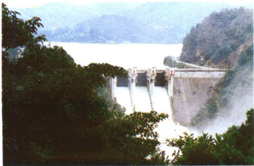
26 龙门滩水电站一级拦河大坝（一、二级电站总装机容量 4.4 万千瓦）
