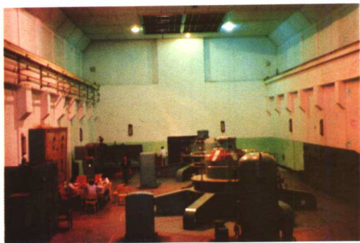
25 山美水电站 2 台 1.5 万千瓦水轮发电机组
