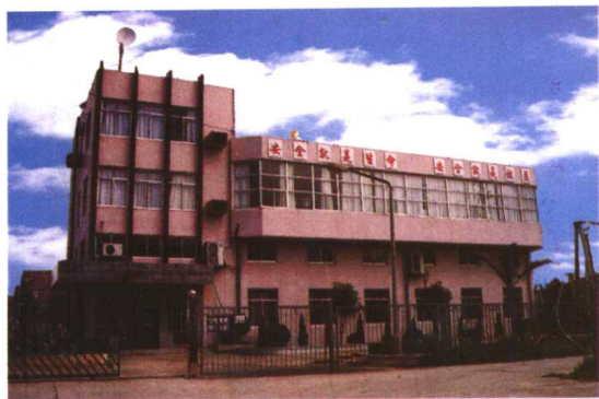
33 220 千伏山兜变电站 (容量 24 万千伏安)
