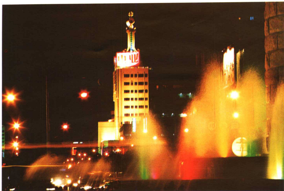
2 泉州电力调度大楼
