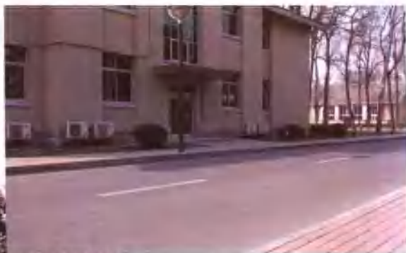
玉泉路园区道路改造完工
