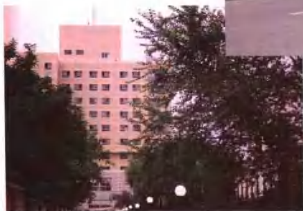
第三学生公寓改造完工
