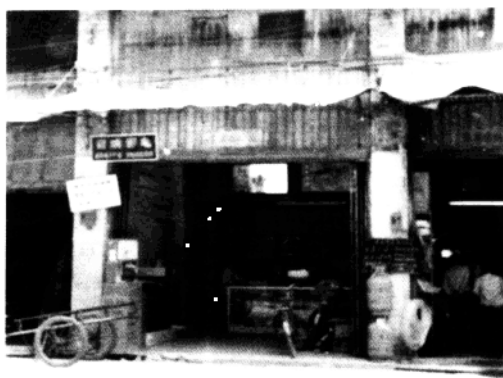
新塘镇解放路的中共 增番工委机关驻地旧址。
