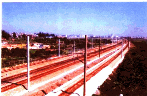
11、改革开放以来，全镇基础设施发生了翻天覆地的变化，广九铁路已改造成为双轨道的准高速铁路。
