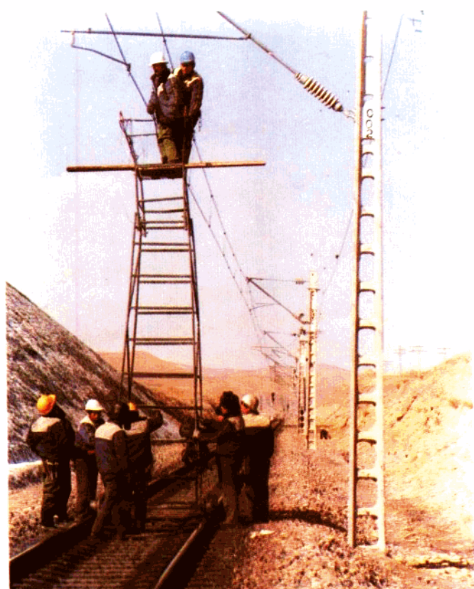
区间接触网调整作业
