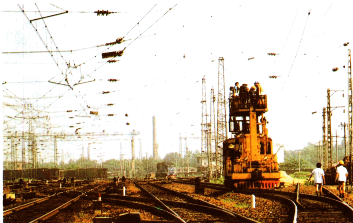
接触网架线车在作业
