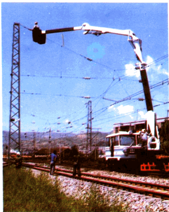
高空车在软横跨作业
