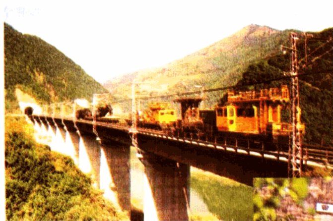
接触网机械化施工车组 在桥上作业
