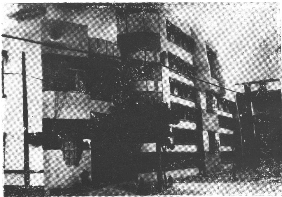
蕉岭县新建机关托儿所全景（1987年）
