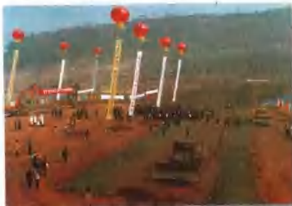
▲1998年11月6日，红旗水库机械化开工的场面。
