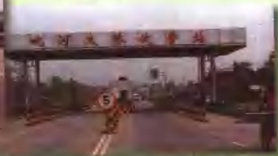
▲投资4000多万元建成成都外环路金堂段，全长12公里，路面宽15米。图为成都外环路毗河大桥收费站。
