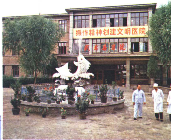
县医院门诊楼
