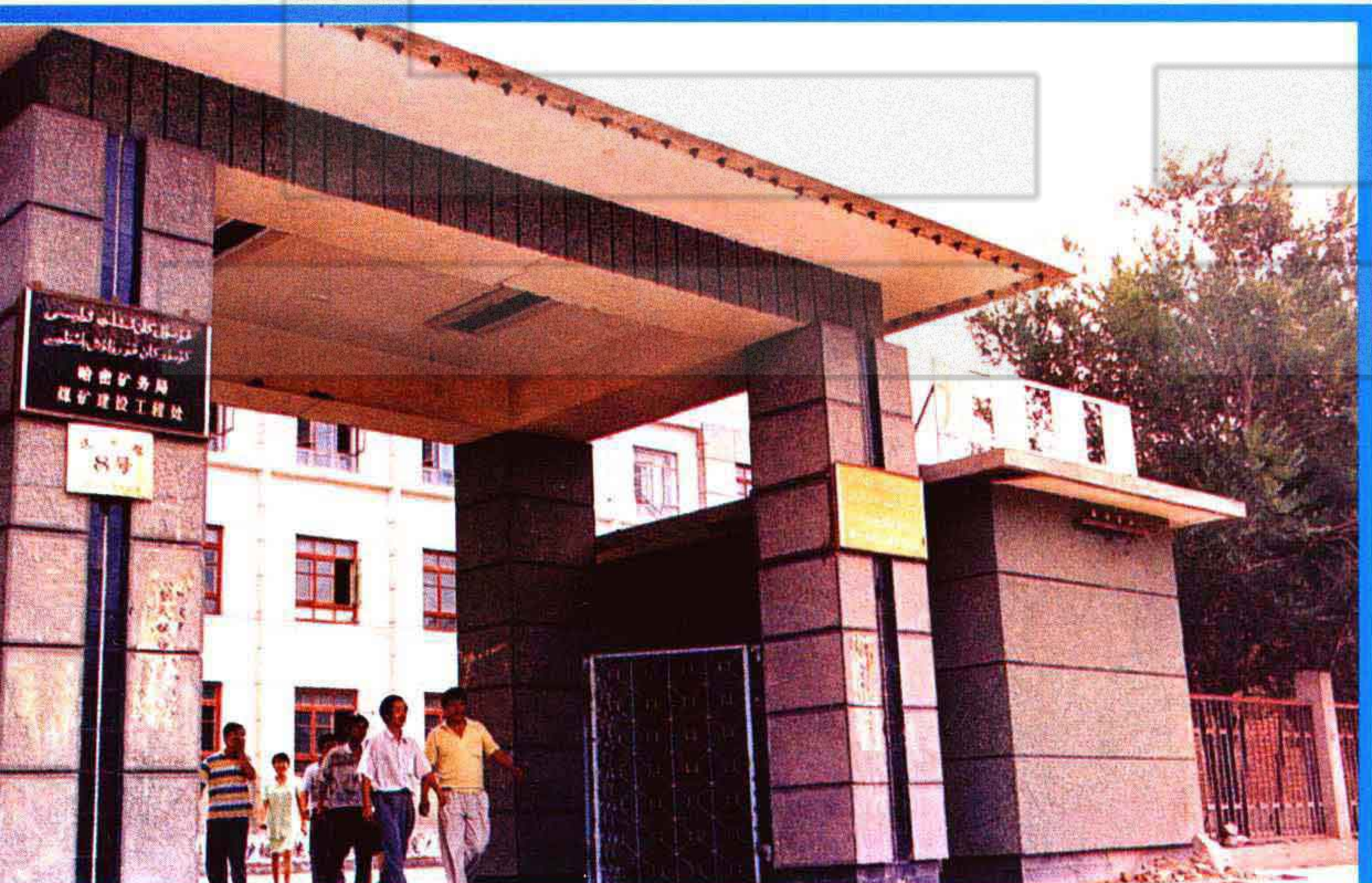
煤矿建设工程处
