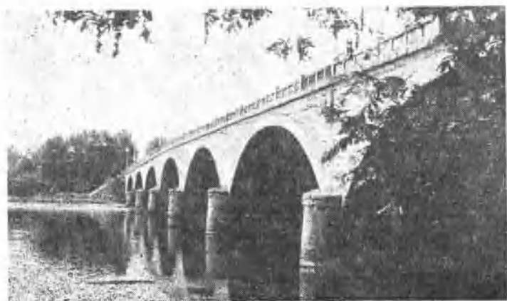
县城 弋江大桥
