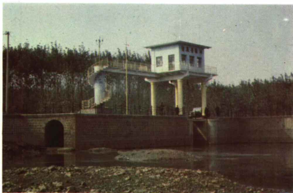
清泉寺渠首工程主体建筑——隧洞全貌
