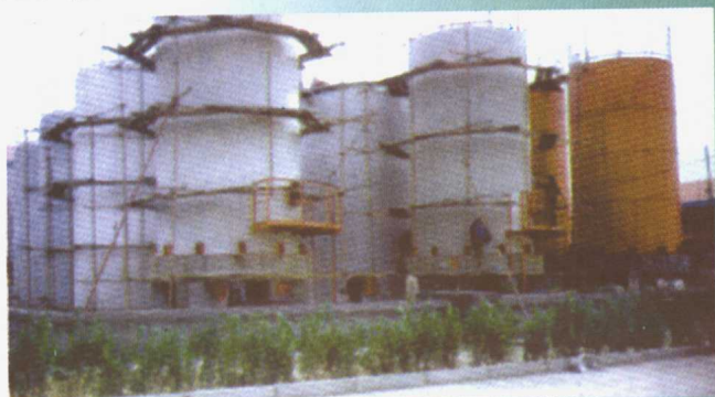
防腐、硅酸镁保温施工
