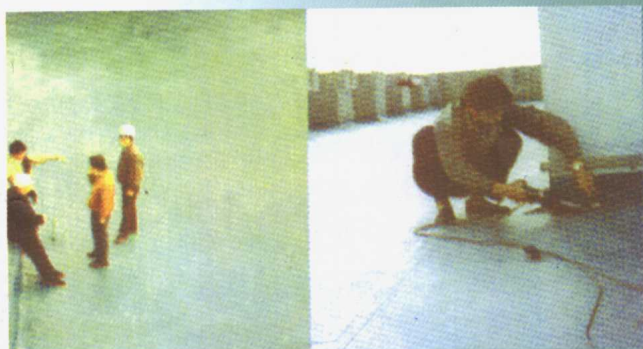
屋面防水工程施工
