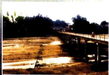
县水利局投资承建的南河店便民桥和护街河堤
