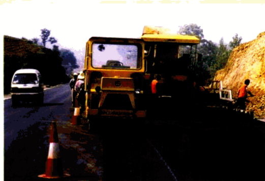
南召县城至南河店二级公路施工现场
