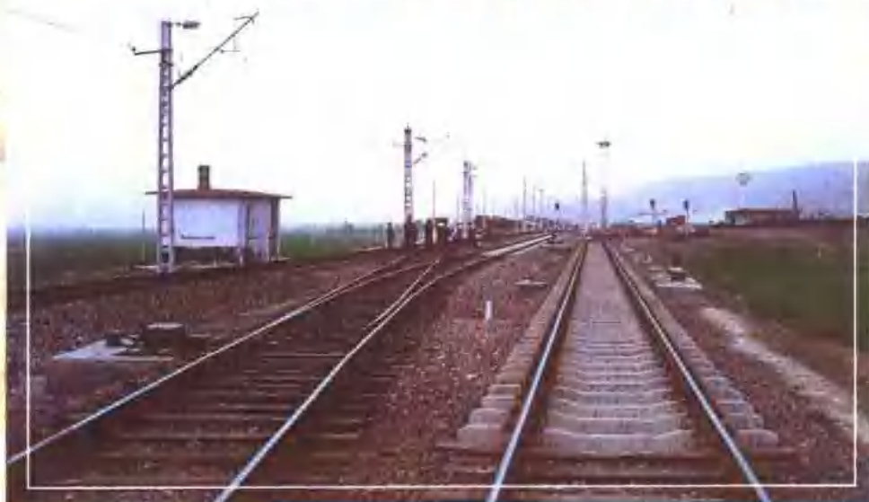
◀ 1997年， 铁一院勘测设计、总承 包的甘肃平凉电厂 铁路专用线正在建设 中
