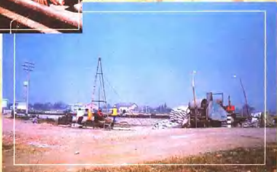
◀ 1997年7月，铁一院在临河水源工程试验中采用贴砾管填砾过滤器新工艺
