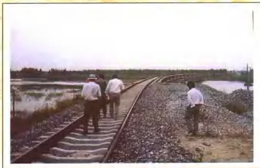
铁一院技术人员在 京九线王村分洪特大桥 (上、中) 和漳沱河特大桥 (下) 工程监理中仔细 检查、严把质量关
