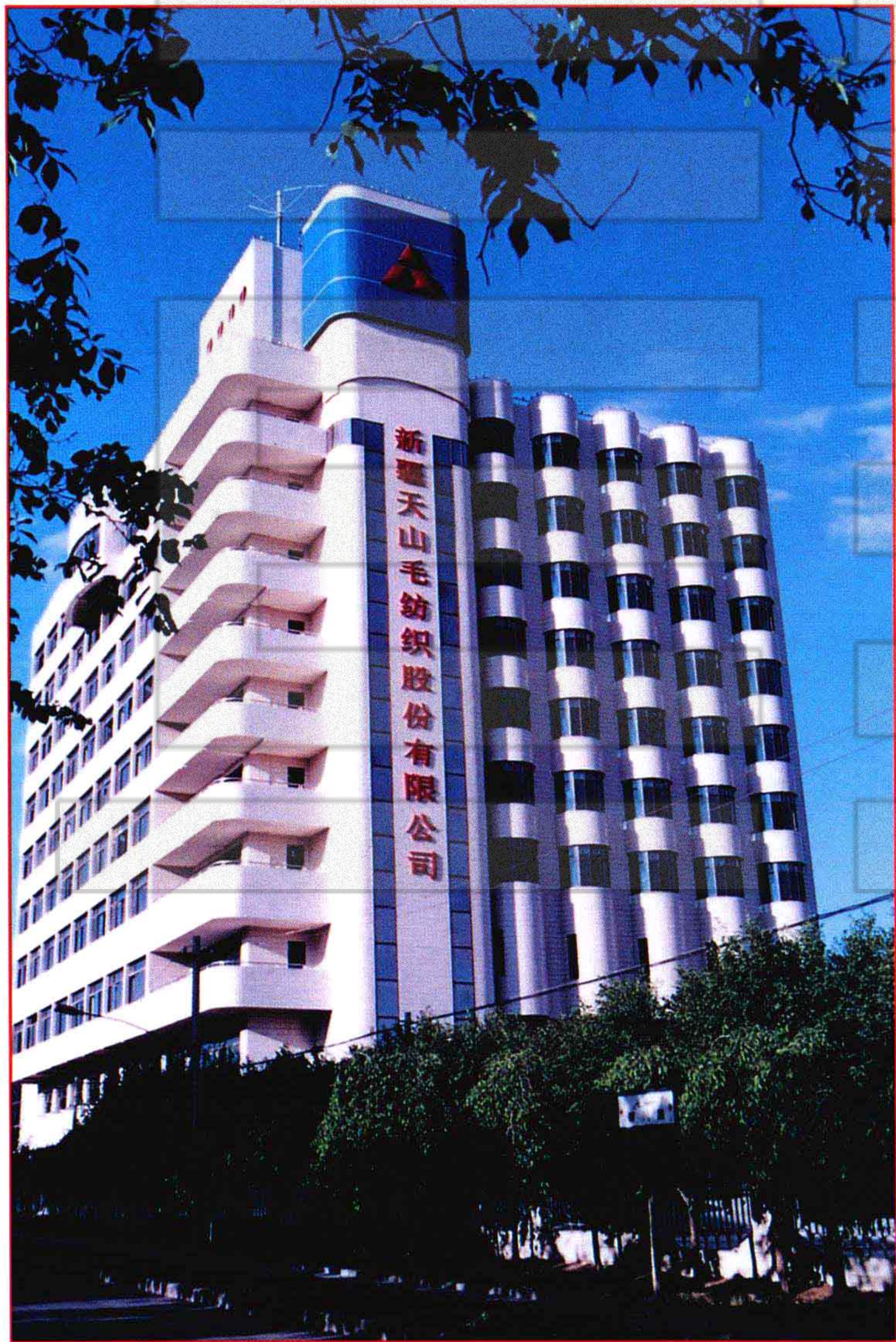
新疆冶金建設公司承建的新疆天山毛紡織有限公司大樓
