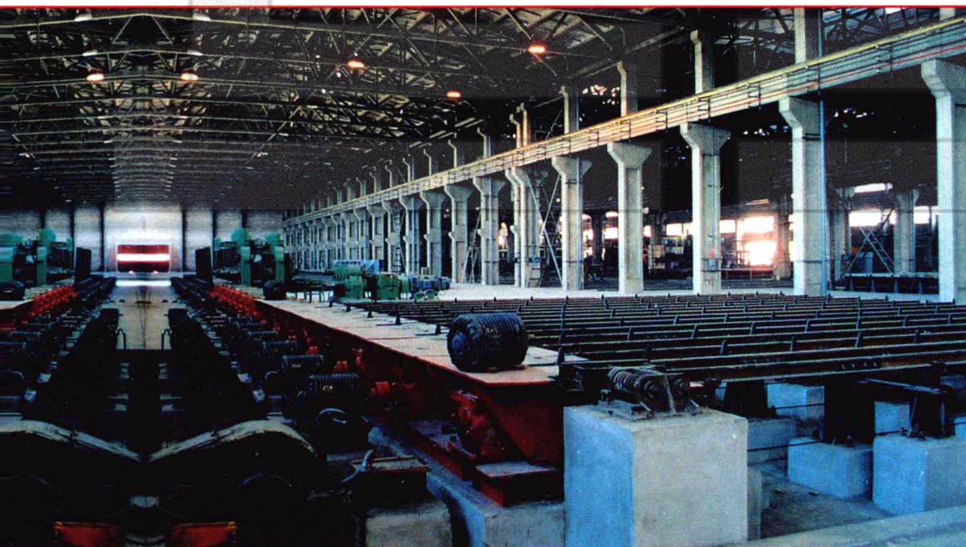
新疆冶金建設公司為八鋼承建的 650 車間，建築面積 2.7 萬 m^2 ，為烏魯木齊建築之最
