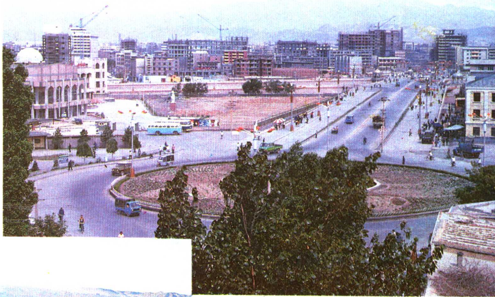
建设中的市区
