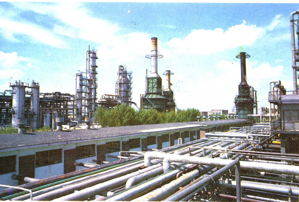
石油化工总厂（二）
